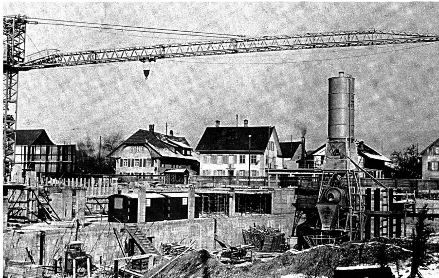
Unter Zuhilfenahme modernster Maschinen schreiten die Bauarbeiten rasch voran. Am
