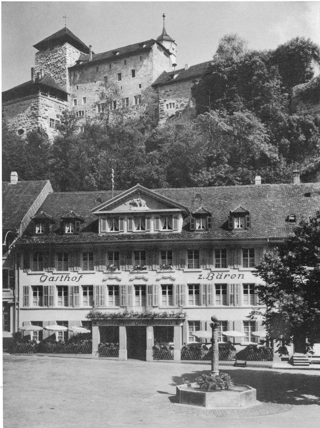
Abbildung 11: Der «Bären» in neuem Gewand, nach dem 1922— 1923 durch Architekt von Niederhäusern erfolg- ten Umbau. — Die Aufnahme stammt ungefähr aus dem Jahre 1950. Beim Eingang ist eine luftige kleine Gartenwirtschaft — oder müsste man
