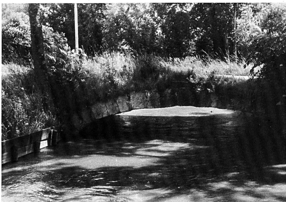
Seit Jahrhunderten leitet der Tych einen wesentlichen Teil des Wiggerwassers auf Mühlen und in die Wassermatten. Als Zeuge vergangener Zeiten steht dieses Bogenbrücklein in Nigglishäusern unter Heimatschutz und dient immer noch dem Verkehr.
