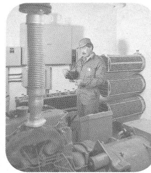
Anlage- und Reparaturdienst
