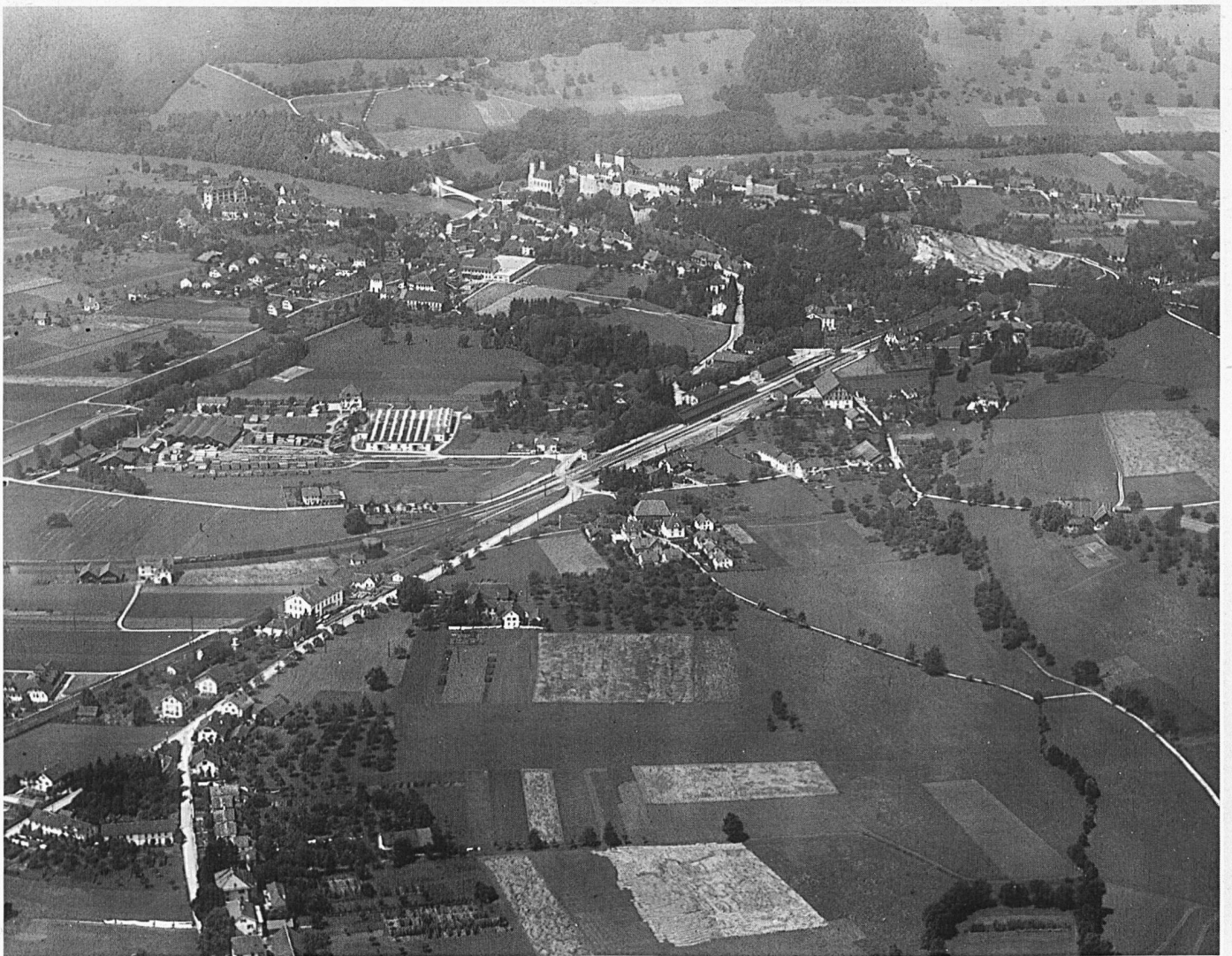
Südlicher Gemeindeteil, von Süden her (Oftringen) aufgenommen, ca. 1922. Von den Werkanlagen der Firma Franke AG ist noch nichts zu entdecken; an der Stelle der Anlagen der Chemischen Fabrik G. Zimmerli AG steht noch eine Sägerei.
