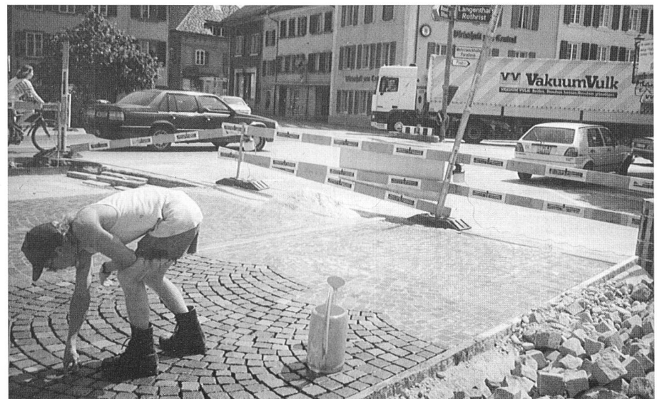
Pflasterungsarbeiten bei der Bushaltestelle Stadtgarten.
