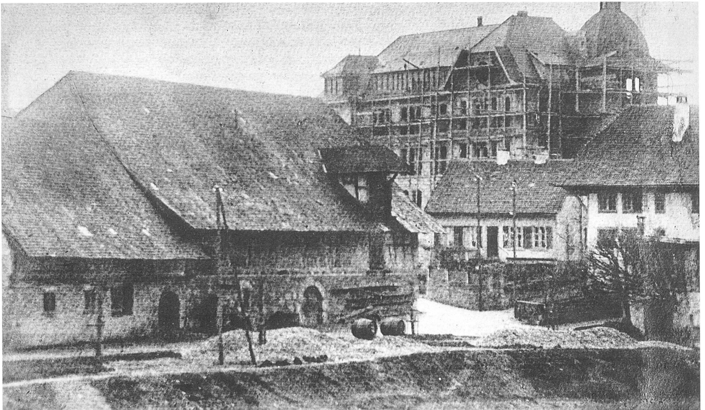
Das Schulhaus Hofmatt während den Bauarbeiten.
