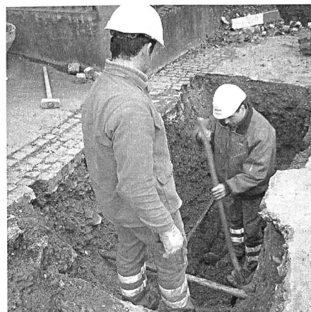
Fachleute bei einem Sondierschlitz.
