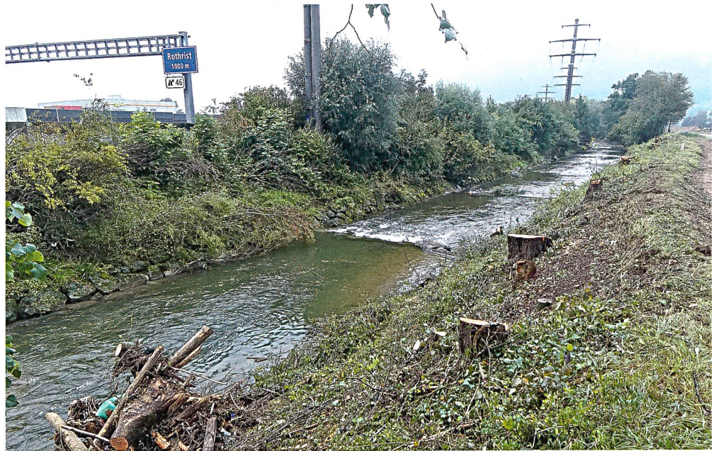
Altes Flussbett während des Ausholzens (September 2014)
