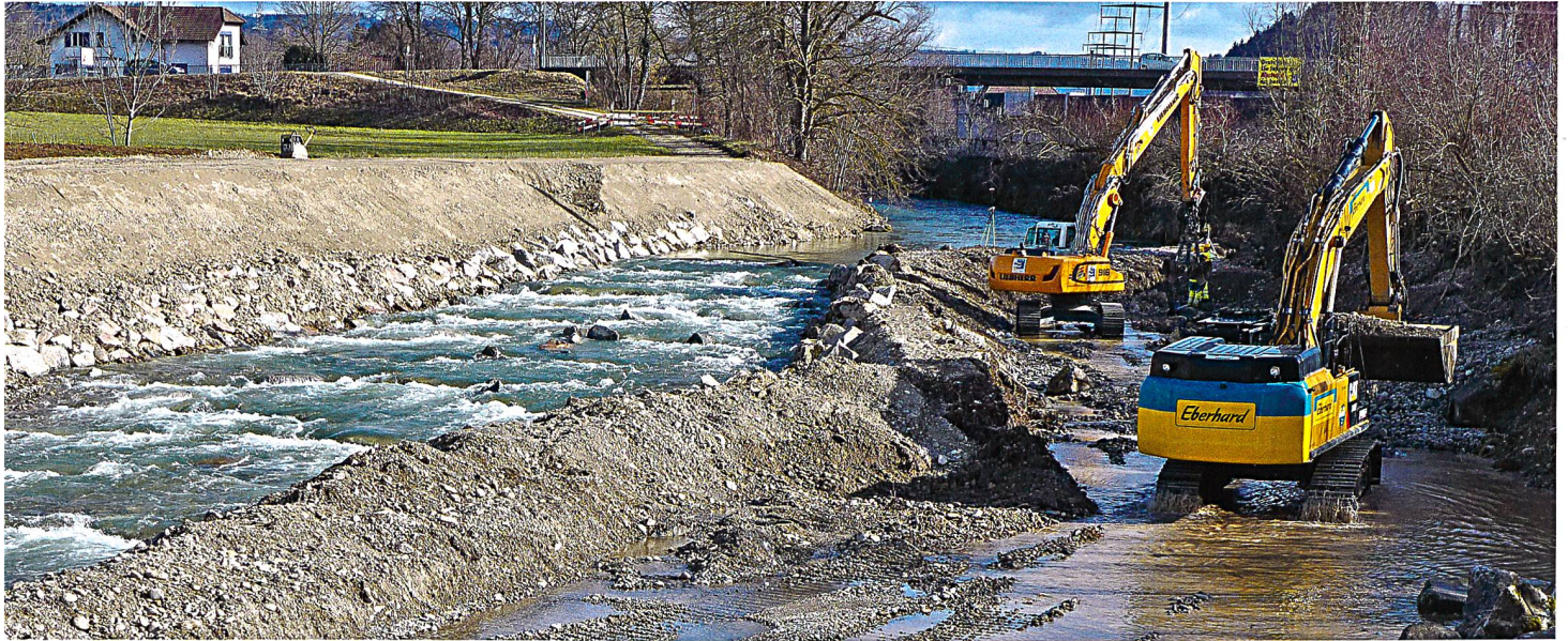
Das Wasser flutet das neue Flussbett (März 2015)
