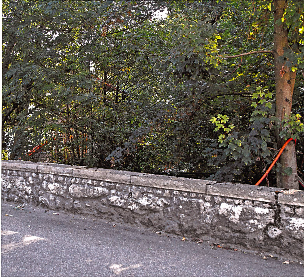
Die aktuelle Brücke über die Pfaffnern in der Rishalde. Schon bei der ersten «Aargauerstrasse» musste die Pfaffnern überquert werden.
