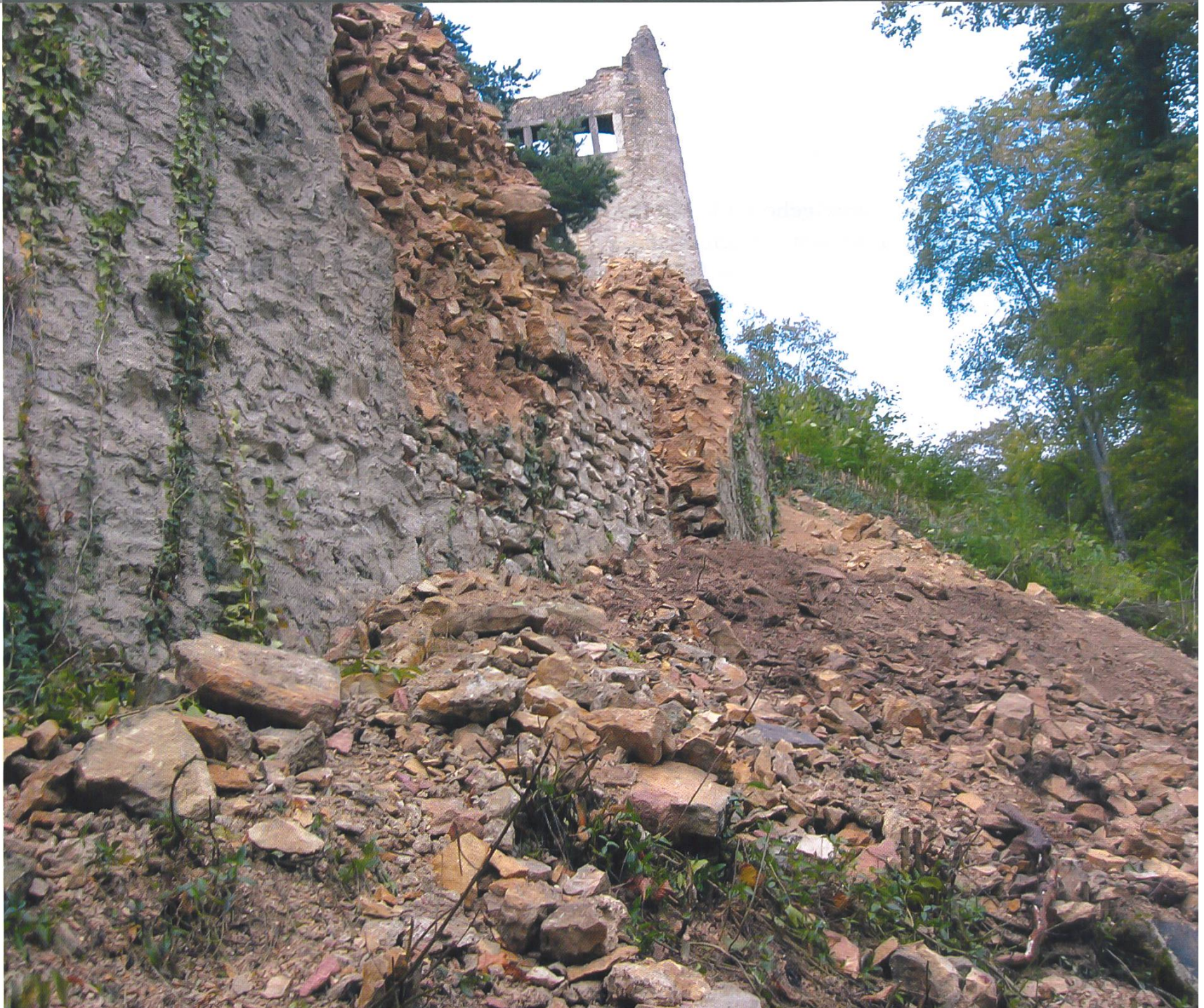
Löffelfingen, Homburg. Schadensbild nach Beginn der der Reparaturarbeiten.
