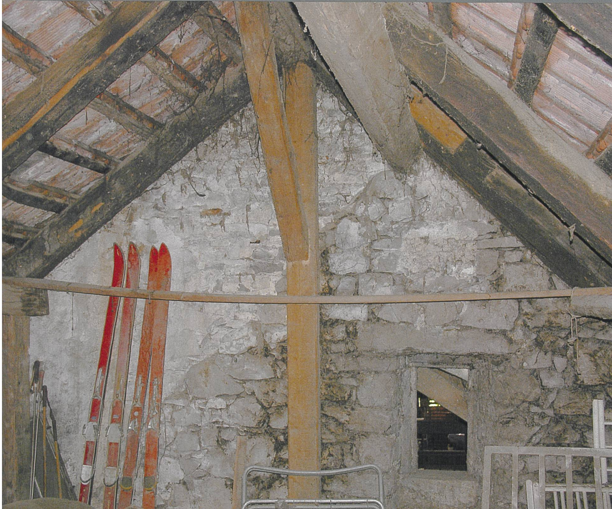
An der östlichen Giebelmauer ist die jüngere Aufmauerung zu erkennen. Der Dachstuhl weist neue, unterstützende Stuhlsäulen auf.
