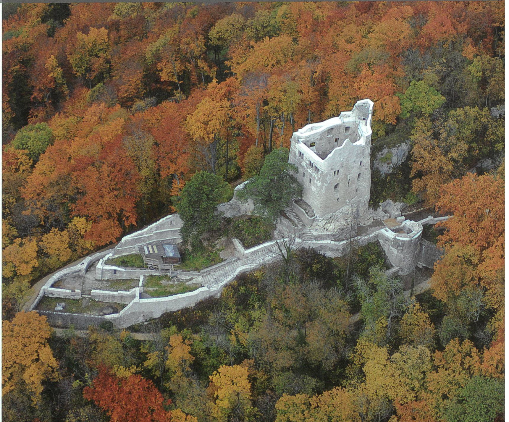
Läufelfingen, Homburg, Oktober 2010. Die frisch restaurierte Anlage im herbstlichen Kleid (Kantonsarchäologie Zürich).
