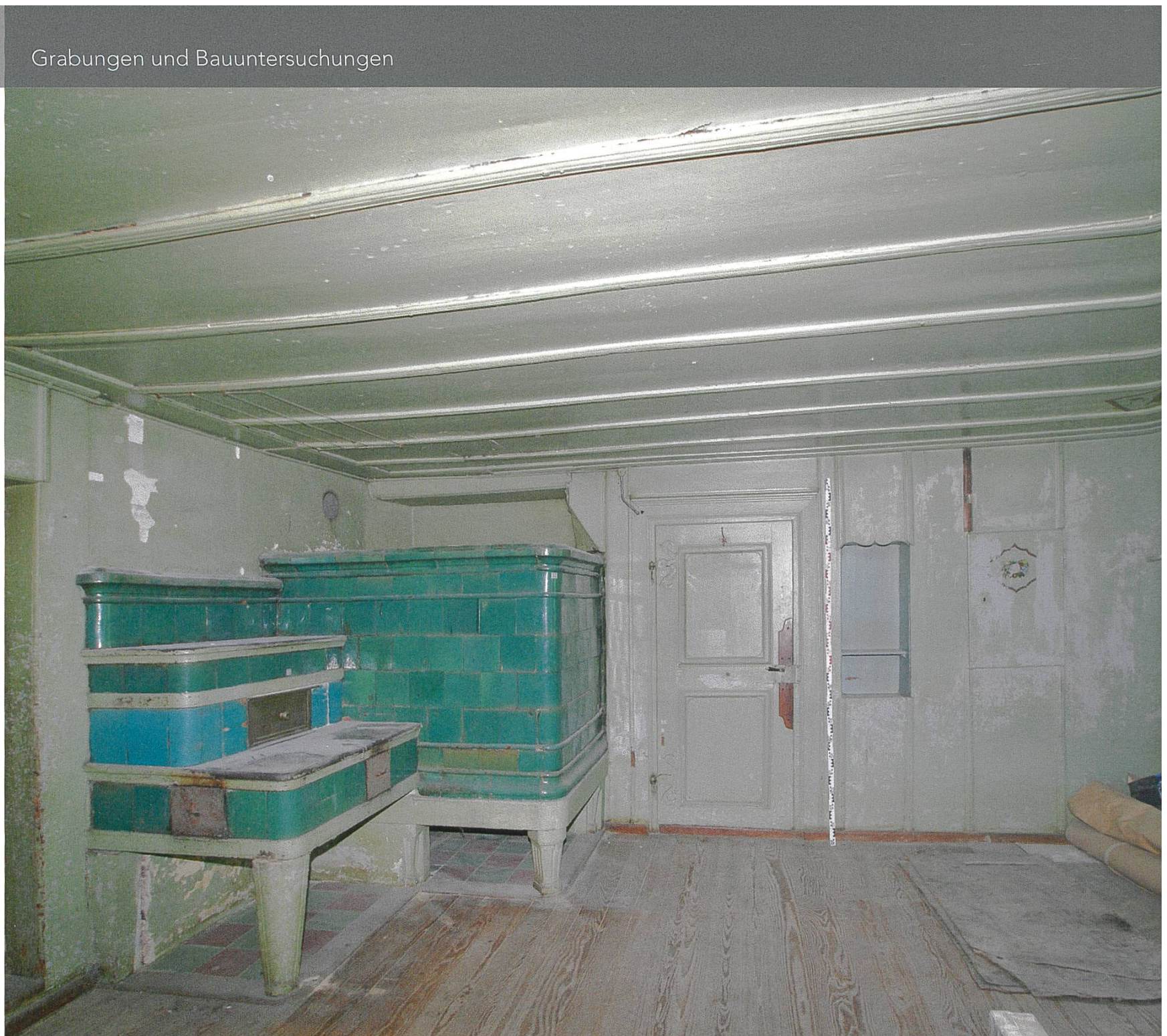
Gelterkinden, Tecknauerstrasse 17. Die Stube im Erdge- schoss mit Wand- und Deckentäfer.
