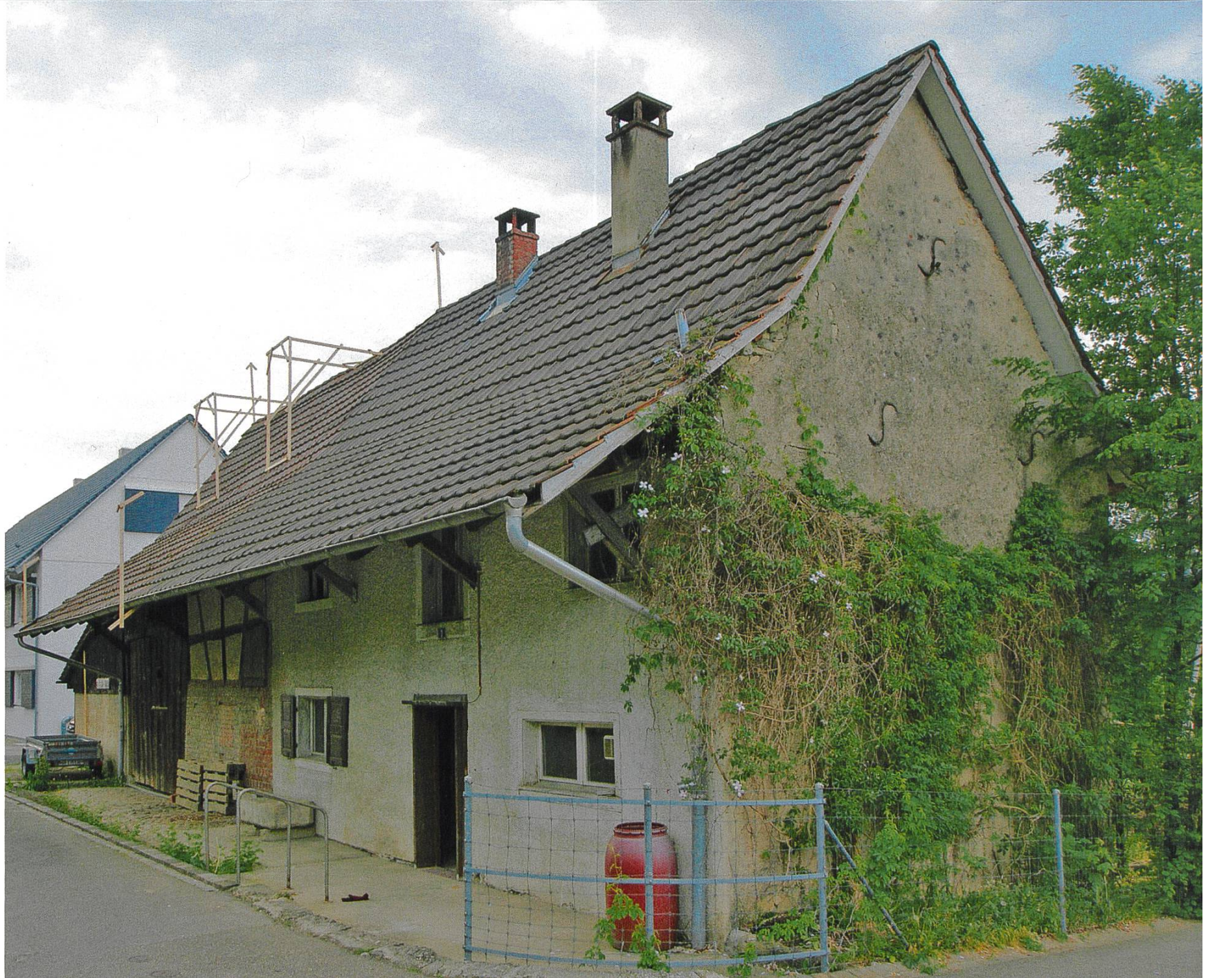
Biel-Benken, Strehlgasse 2. Blick auf die gassenseitige Fassade und die gemauerte, west- liche Giebelseite des Untersuchungsobjekts, nach Südost.
