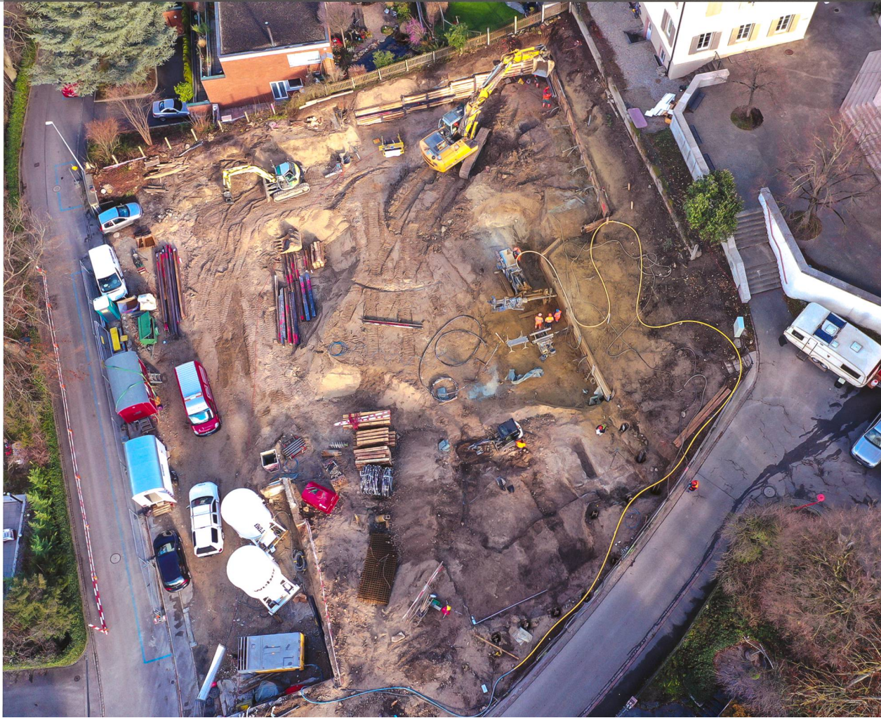
Binningen, Florastrasse. Die Ausgrabung befindet sich am Südrand der Parzelle. Weiter im Norden ging der Baustellenbetrieb parallel weiter. Blick gegen Norden.
