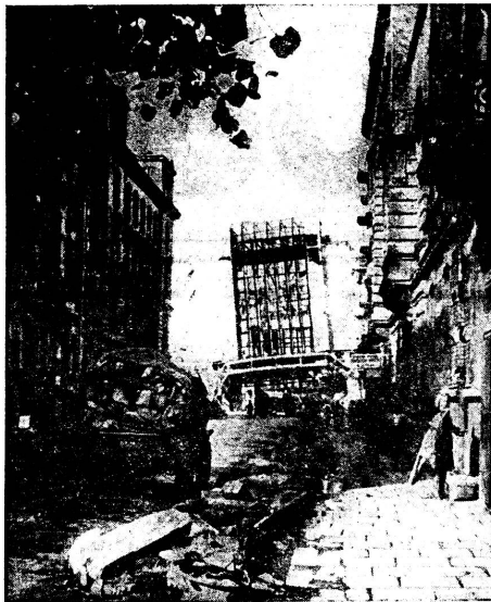
Das Gerippe des Hauptbahnhofs von Warschau La carcasse de la gare principale à Varsovie
