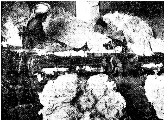
Die in jedem Wollhaar-Büschel enthaltenen Samenkörner werden durch diese Entkörnungsmaschinen grösstenteils entfernt. Aus den Körnern gewinnt man Oel und Viehfutter.
