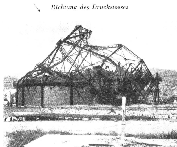
Abb. 4. Luftdruckwirkung an einem Gasometer in Nagasaki in 1 km Abstand vom Schadenzentrum. (Reprod. aus Report of the British Mission to Japan.)
