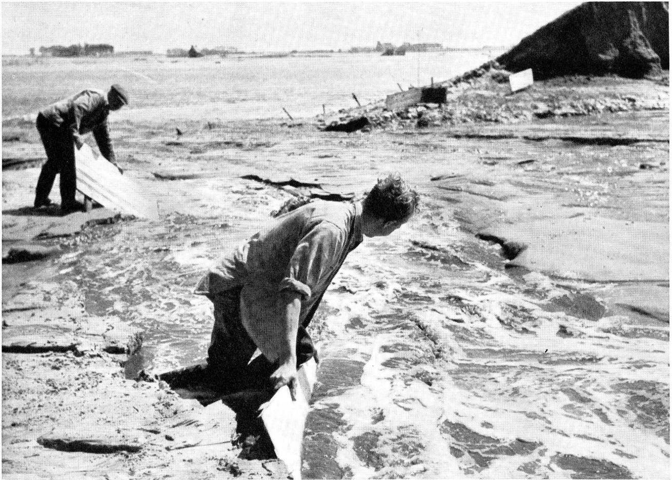
Arbeiten an einem kleineren Deichloch mit geringerer Strömung. Foto Schimmelpennigh, Scheveningen.
