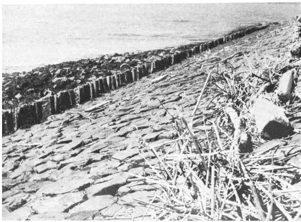
Das Bild links zeigt den Deichfussmantel aus Basaltsteinen im Bienenwabennmuster. Foto Marguerite Reinhard.
