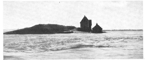
Durch die Breschen ziehen die Gezeitenströme ein und aus. Wellengang und Dünung sind oft sehr hoch. Dadurch werden die Deichreste umfressen und die Breschen vertieft. Die Rinnen werden breiter und tiefer und schneiden immer mehr ins Land hinein.
