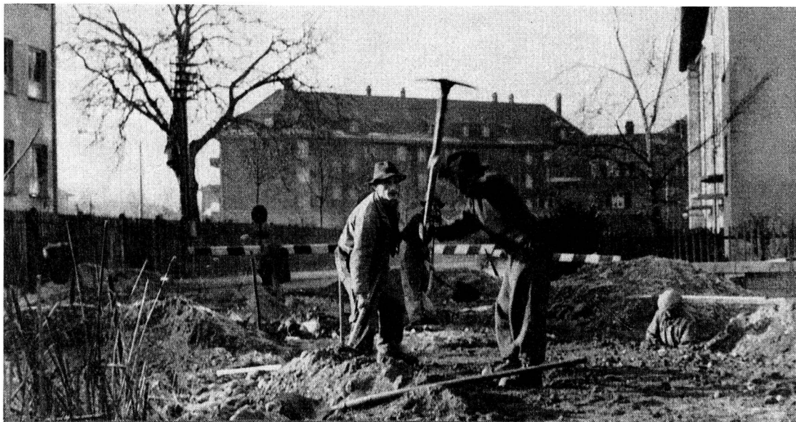
Auf dem Areal des Schweizerischen Roten Kreuzes auf dem Wankdorffeld, unmittelbar neben der Armeepotheke, rückten im Frühjahr 1953 die ersten Arbeiter an, um mit dem Bau des Blutspende-Zentrallaboratoriums zu beginnen.
