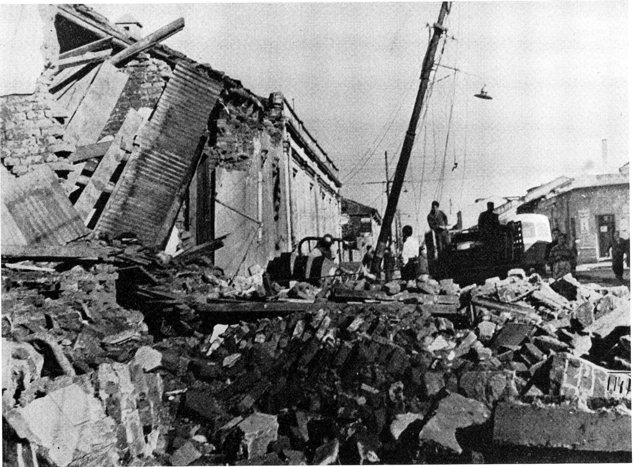
Unser Bild zeigt eine vom Erdbeben zerstörte Strasse der grauenhaft heimgesuchten chilenischen Stadt Concepción. Kein einziger Gebäudeblick dieser Stadt blieb ohne Schäden.
