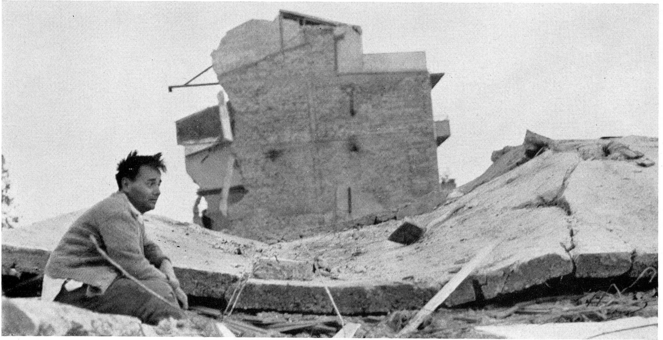
Die Erde bebte in Skoplje im jugoslawischen Mazedonien nur wenige Sekunden. Am frühen Morgen des 26. Juli. Doch welch eine grauenhafte Wirkung! 80% der Häuser zerstört, 120 000 Menschen obdachlos.
