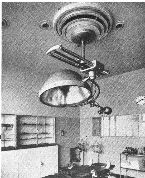
Klimaanlage «System Häusler» in Operationssaal eines Spitals
