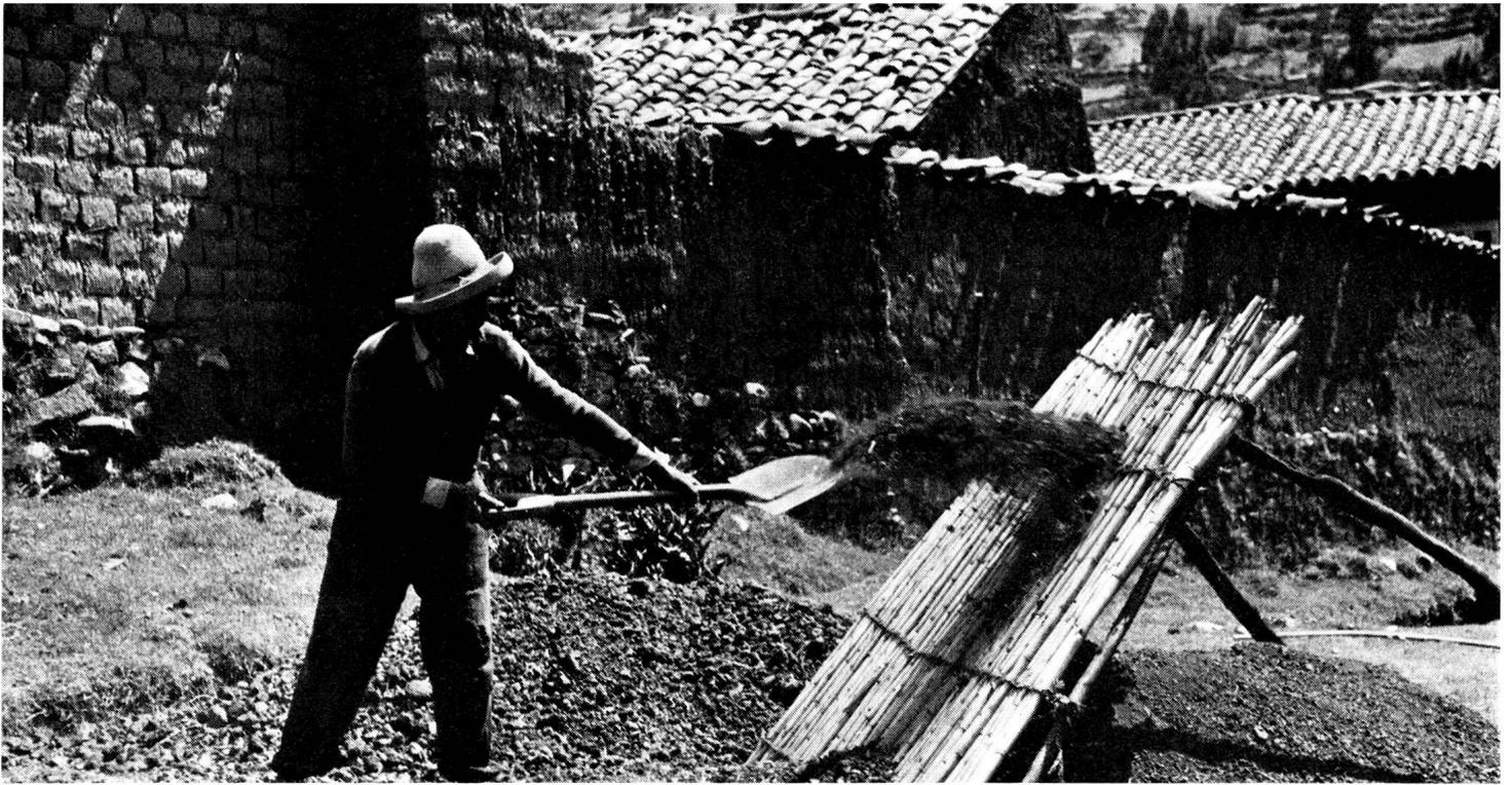
*Für die Herstellung des Baumaterials wird feingesiebte Erde mit Wasser angerührt, mit kurzgehacktem Steppengras vermisch und in Formen gepresst. Diese Ziegel werden an der Luft getrocknet.*
