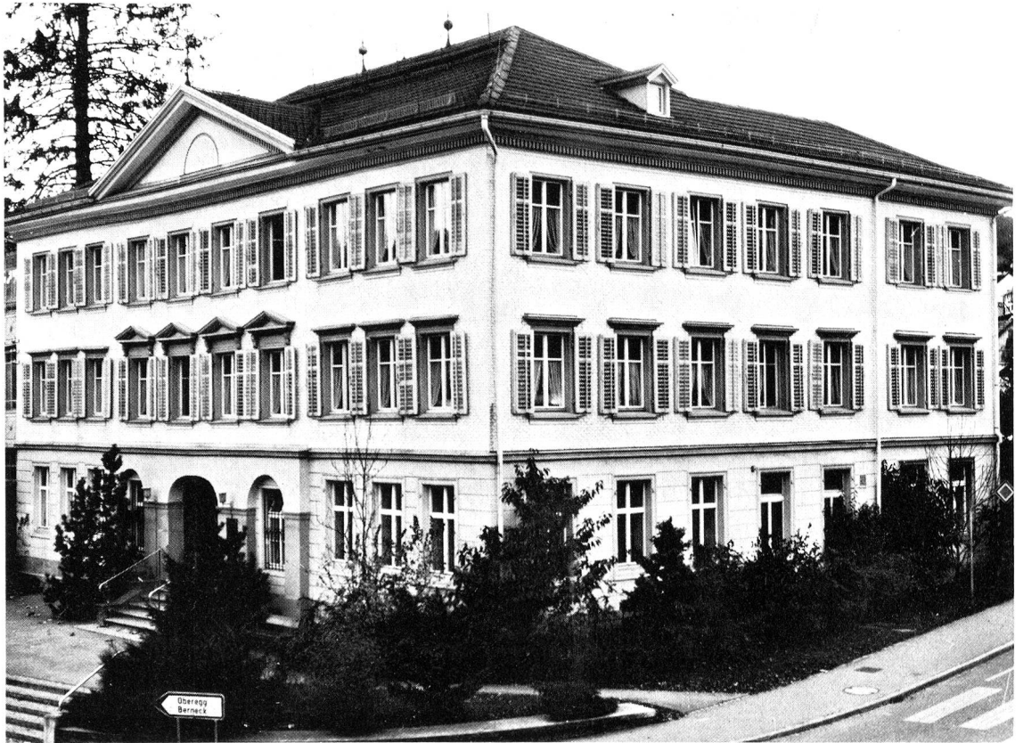
Das Bezirksspital Heiden. Dunant lebte von 1892 bis 1910 im zweiten Stock. Zum Eckzimmer gehören die drei äusseren Fenster der Vorderfront rechts und die zwei vordersten Fenster der Seitenwand.
