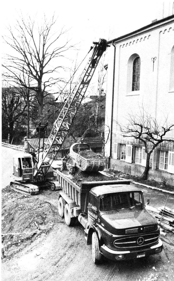
*Die Bedienung dieses Baggers mit beweglichen Teilen verlangt viel Fingerspitzengefühl, Der Löffel fasst 1 m<sup>3</sup>, was hier einem Gewicht von etwa 3 t entspricht. Der Dreifachlaster kann 20–25 t laden. Im ganzen waren etwa 3800 m<sup>3</sup> Aushub wegzuführen.*
