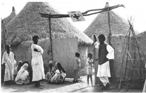
① Die SRK-Poliklinik in Wad Scheriffee. Sie entspricht in der Bauweise den Wohnhäusern der Flüchtlinge: Mätern aus Lehm, das Dach aus Stroh.
