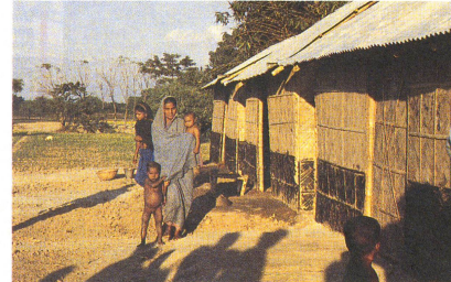
Alle Häuser sind gemäss der in Bangladesh üblichen Bauweise hauptsächlich aus einem Bambusgerüst, das an Bambuspflösten befestigt wird, errichtet worden.
