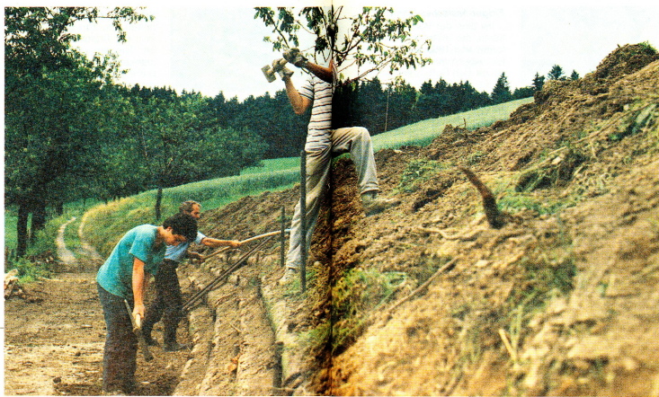
Freiwillige beim Wegbau bei Widmatt.
