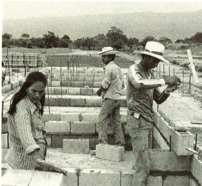
In Armero-Guayabal wird nach dem Prinzip der «autoconstrucción» gebaut: Die Begünstigten arbeiten mit. (Bild: Kurt Bolliger)
