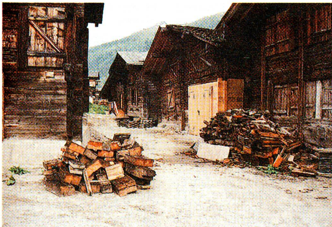
Hell heben sich die neugezimmerten Balken vom dunklen Holzwerk ab, das die Flutwelle überstanden hat.
