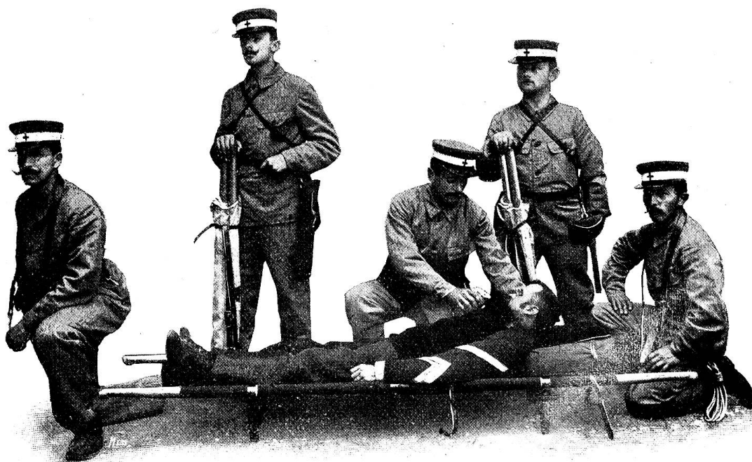
Equipement d'un groupe de la Colonne de transport auxiliaire de Bâle.
