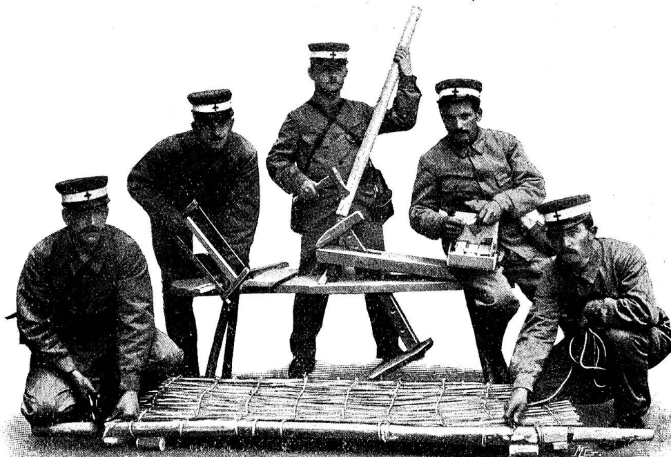
Equipement d'un groupe de la Colonne de transport auxiliaire de Bâle.
