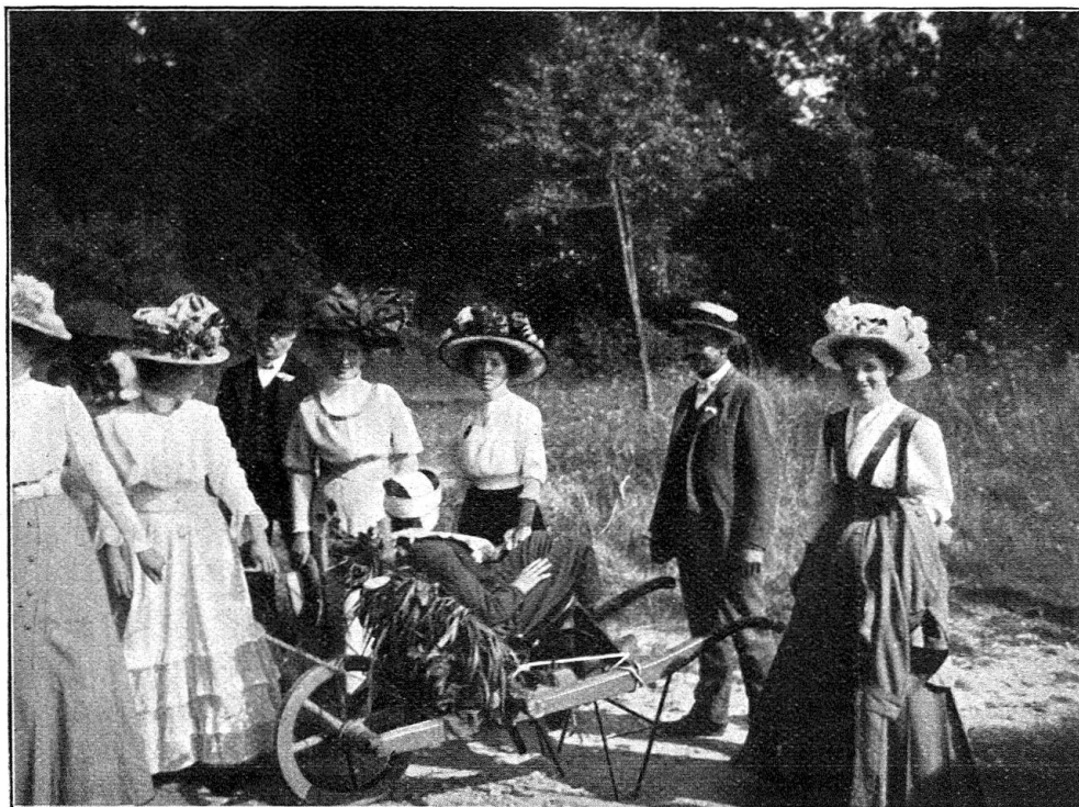
Les samaritains de Fribourg transportent un blessé sur une brouette transformée en voiture à blessés.
