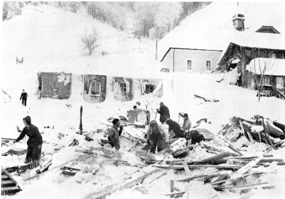
A Riemenstalden (Schwyz) l'école et l'auberge ont été détruites, l'église a été remplie de neige et a subi de gros dégâts. Par miracle il n'y a pas eu de victimes (Clichés Richter.)
