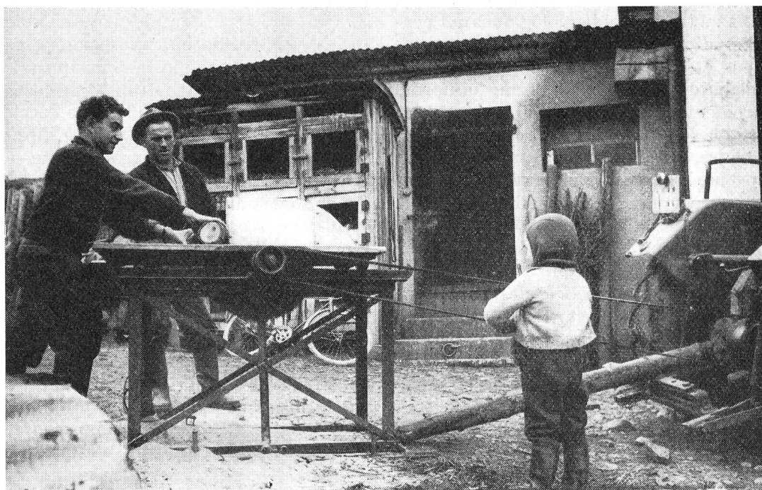
L'accident n'est pas accidentel... Une scie mécanique mal assurée et entraînée par un tracteur, un câble de fortune, pas de protection, un voisin qui bavarde, un enfant à proximité, autant de « motifs » qui peuvent provoquer un accident.
