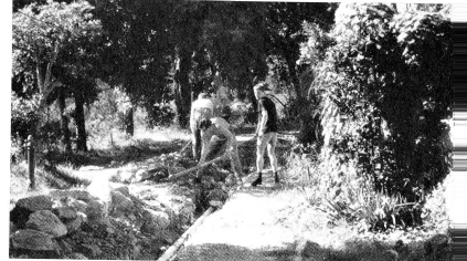
La pose des canalisations, en bonne voie aujourd'hui, a donné pas mal de soucis...
