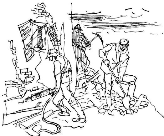
Travaux de déblaiement.
