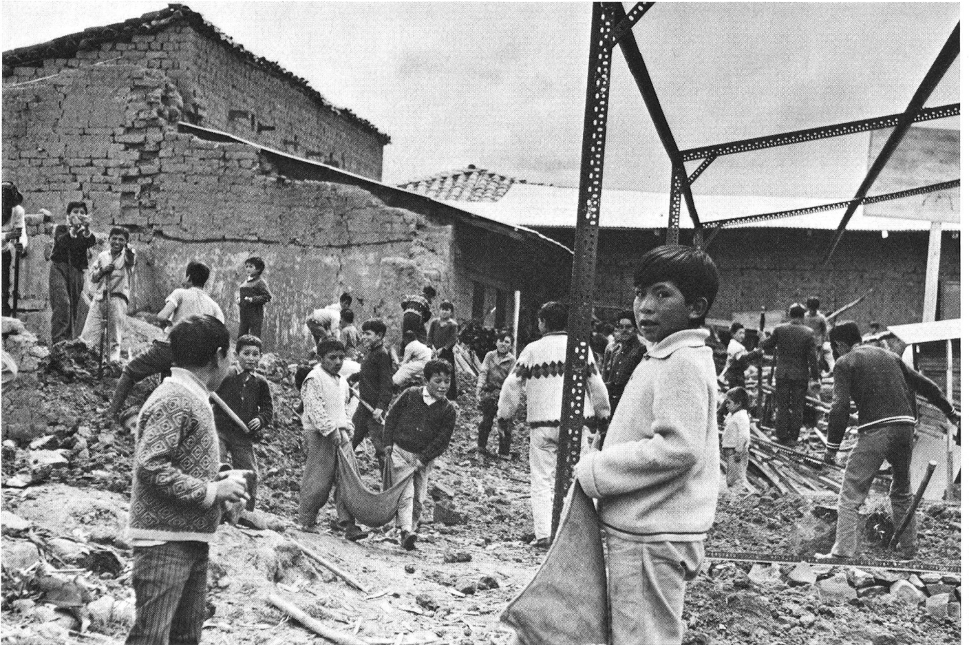
Les petits écoliers de Piscobamba déblaient les ruines de leur école et vont aplanir le sol de la nouvelle construction.
