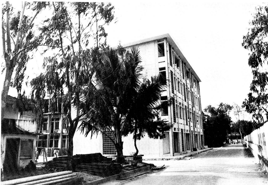
Une partie du nouvel hôpital de Da Nang.
