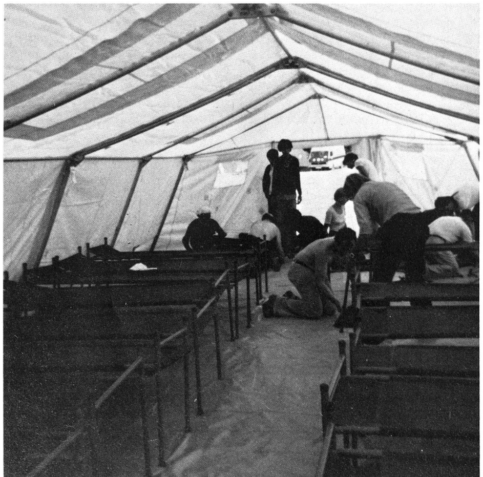
L'hôpital de secours suisse en construction: ici, l'une des tentes de 33 lits.
