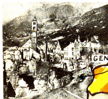
Incendio di Airolo (Ti).
