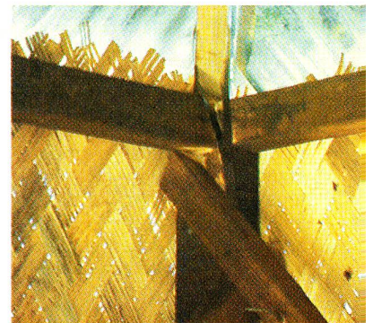
Per la costruzione viene sistematicamente utilizzato materiale locale, come foglie di bambù, in questo particolare dell'interno.
