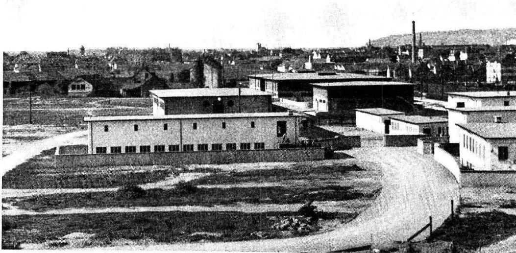
Fig. 1. a) Vue de l'Institut vaccinal, côté sud : derrière le bâtiment principal on voit les bâtiments de destruction des cadavres attenants aux abattoirs. — b) Vue de l'étable d'épreuve au sud. A droite de la rue on voit le laboratoire de l'Institut.
