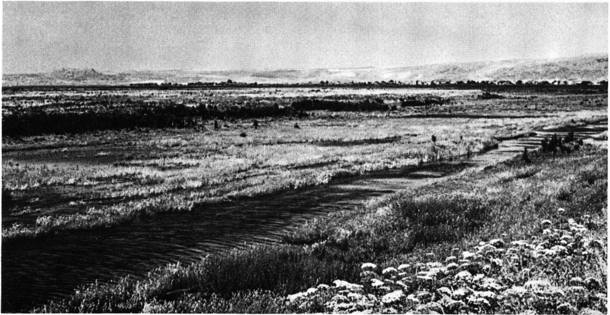
Fig. 1. Canal de drainage envahi par une végétation aquatique et semi-aquatique et qui ne draine plus le périmètre irrigué. Au deuxième plan, marécages secondaires et cultures abandonnées. Les eaux stagnantes ou peu courantes offrent d'excellent gîtes aux larves de moustiques et aux mollusques. En curant ce canal on rendrait service, autant à l'agriculture qu'à la santé publique.
