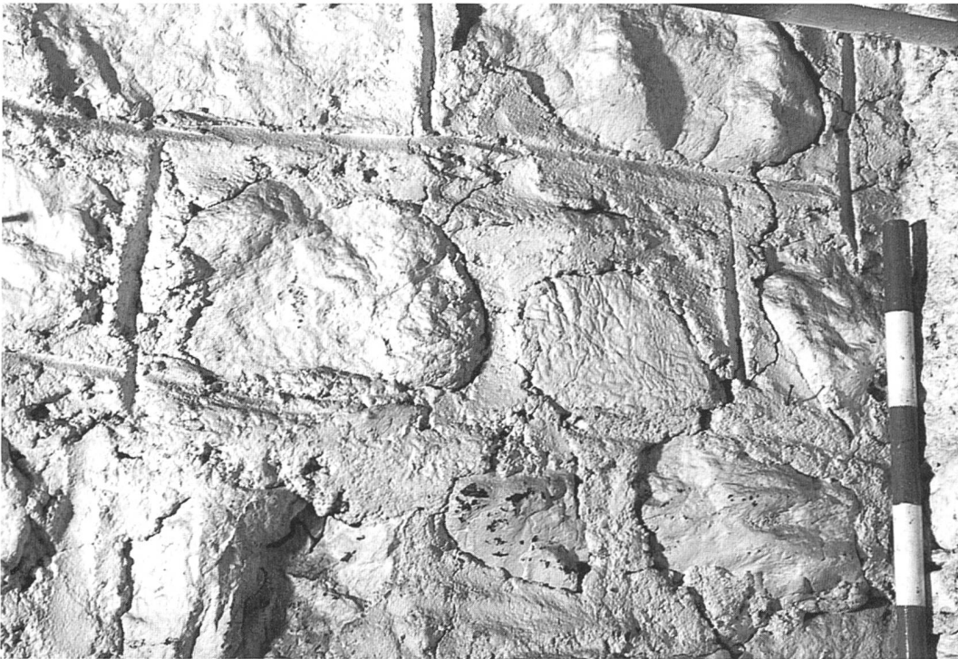
Abb. 36: Der «pietra-rasa»-Verputz mit Fugenstrich zeichnet eine Quaderimitation auf die Innenwände.
