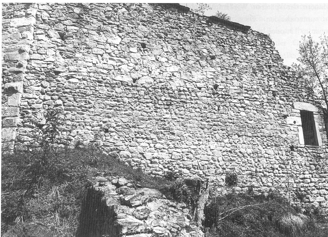
Abb. 67: Die ältere Umfassungsmauer zwischen Kirche und Bergfried, darüber Aufhöhung in der Wiederaufbauphase (horizontale Baunaht).
