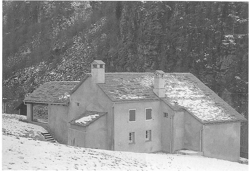
Abb. 156: Selma, Haus Nr. 2. Ansicht von Nordosten.
