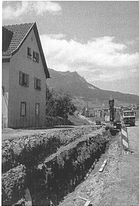
Abb. 92: Savognin, östlich Padnal. Sickerleitungsgraben im Bereich der alten Kantonsstrasse. Ansicht von Südosten.
