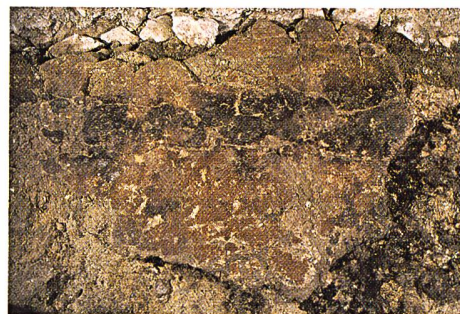
Abb. 29: Müstair, Kloster St. Johann. Sakristei 8, Detailansicht auf den mit rot eingefärbten, karolingischen Mörtelboden, am linken Bildrand die mit roter Spachtelmasse ausgeflickte Stelle.
