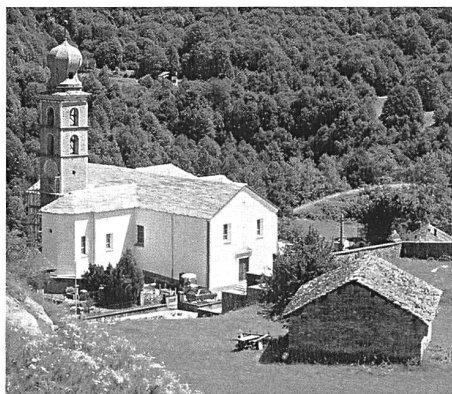
Abb. 121: Mesocco, Crimeo, Pfarrkirche SS Pietro e Paolo. Im Zuge einer Teilrestaurierung wurde im Jahr 2004 auch das Steinplattendach der Kirche erneuert.
